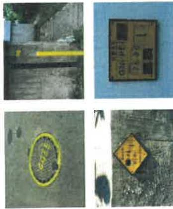
Rețeaua de gaze naturale poate fi identificată după marcajele existente pe reperile fixe (plăcuțe, marcaje cu vopsea etc.); sau în funcție de alte elemente vizuale (banda de semnalizare a lucrărilor în curs, plăcuțe, marcaje cu vopsea etc.).
